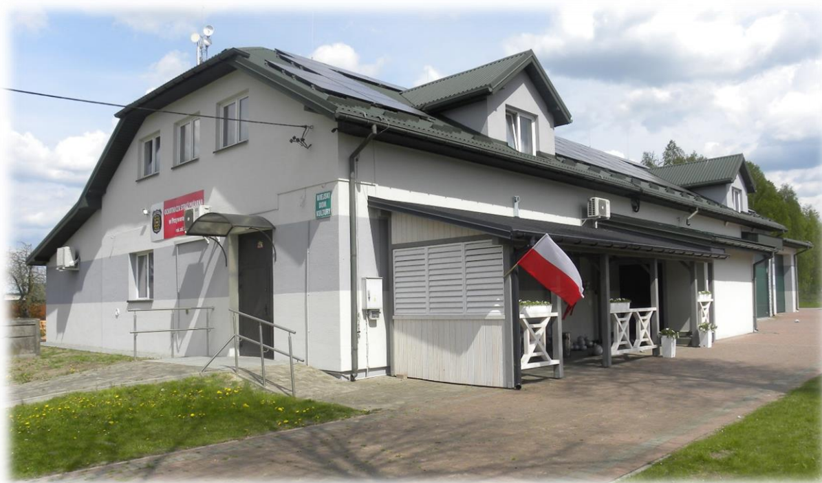
Widok Wiejskiego Domu Kultury po rozbudowie – zdjęcie od strony drogi powiatowej
