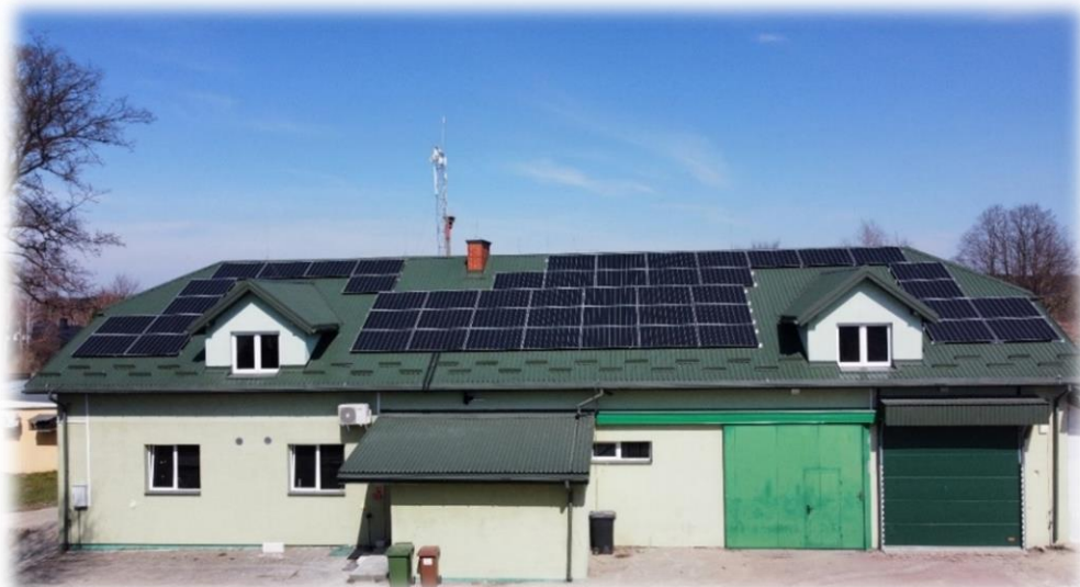
Widok dachu po zamontowaniu paneli fotowoltaicznych
