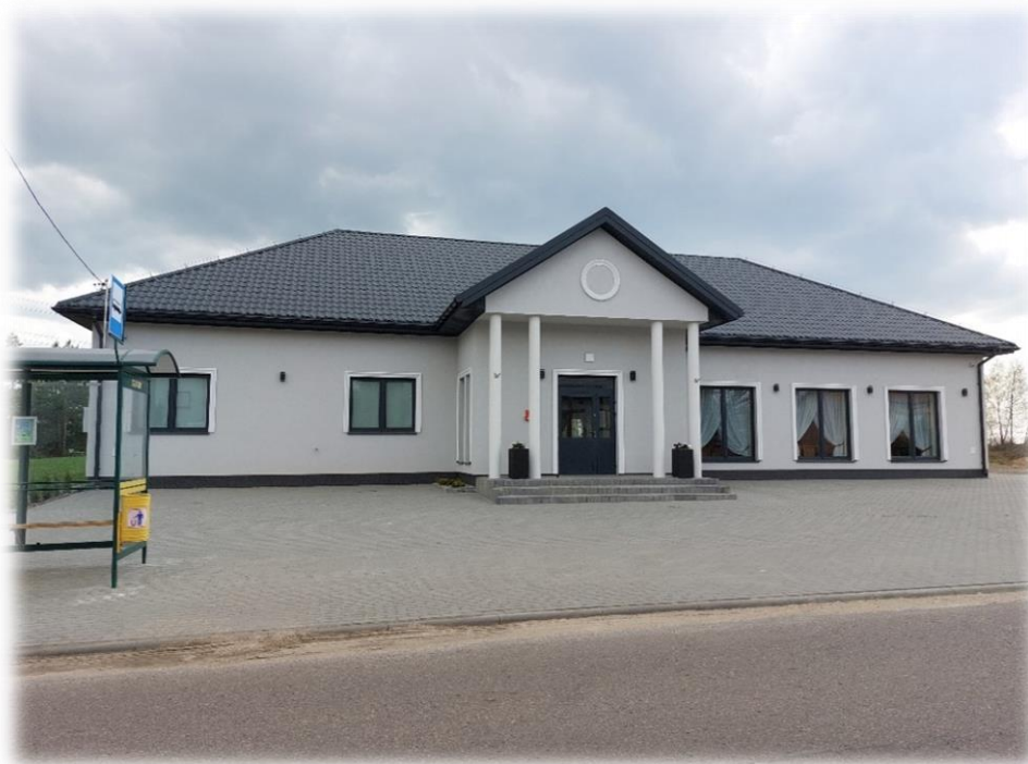
Widok budynku z drogi powiatowej
