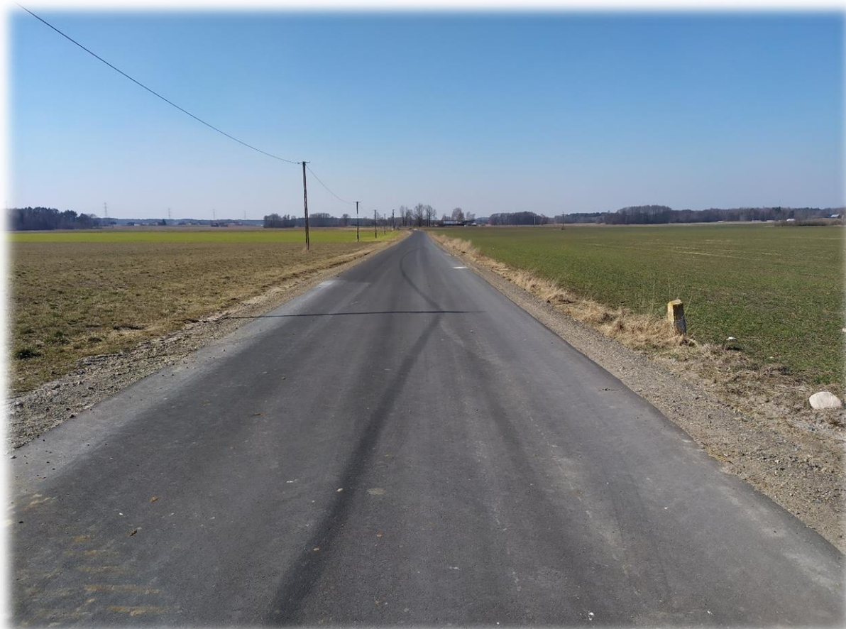
Widok nowego odcinka drogi
