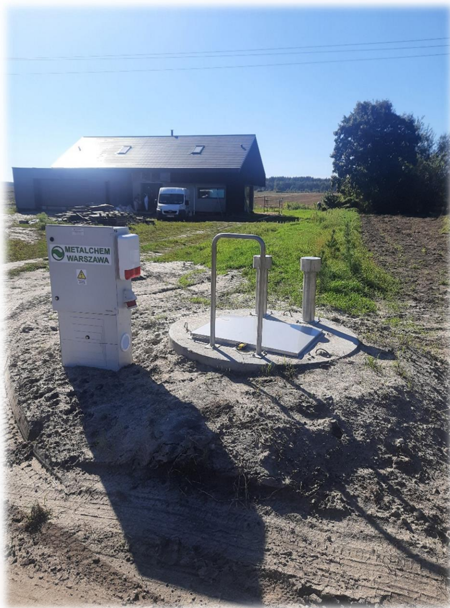
Widok nowej przepompowni
