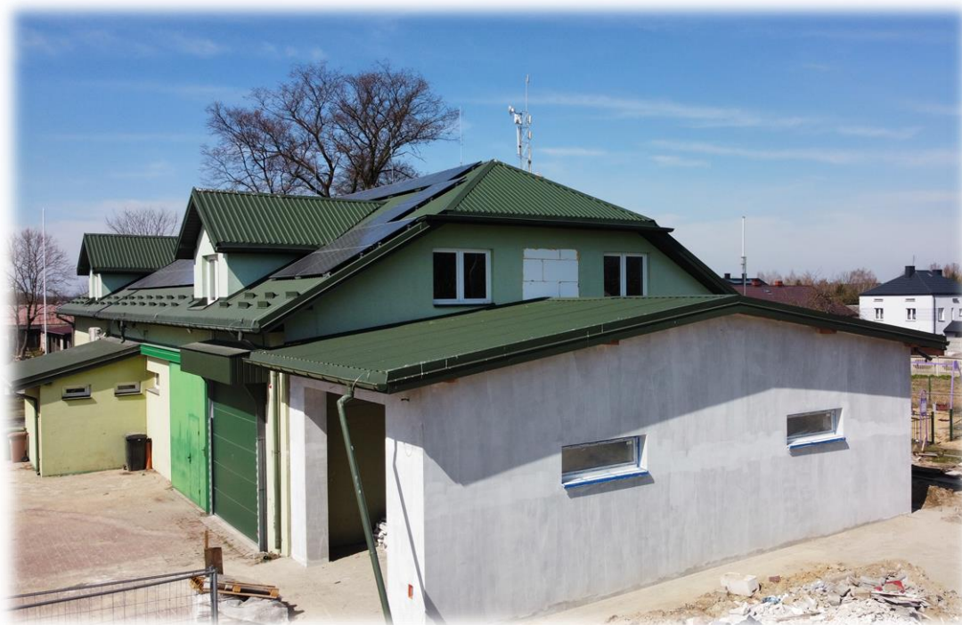
Nowy garaż dla OSP w trakcie budowy
