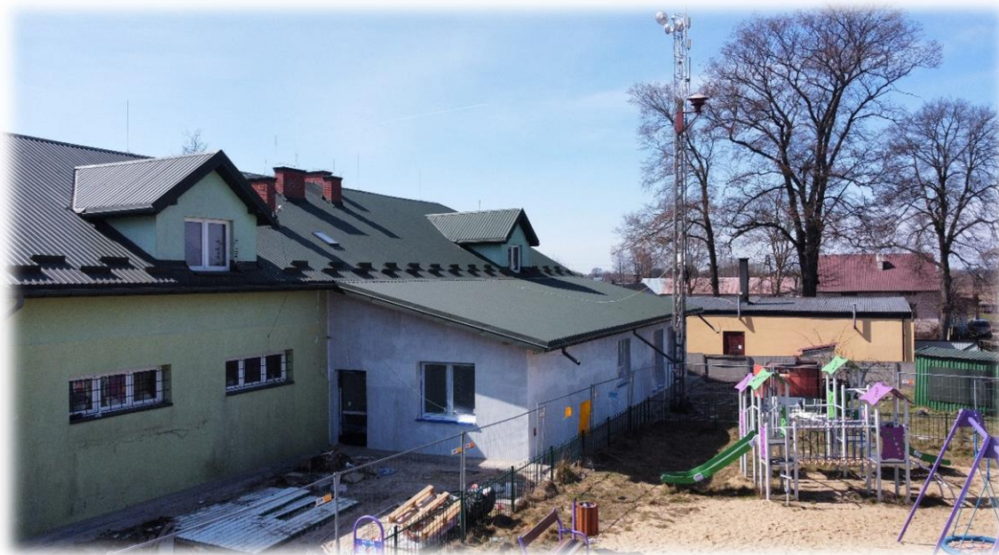
Widok dobudowanej części Sali
